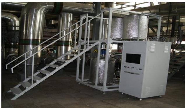
Стационарная установка по автоматическому дозированию ПАВ в систему теплоснабжения
